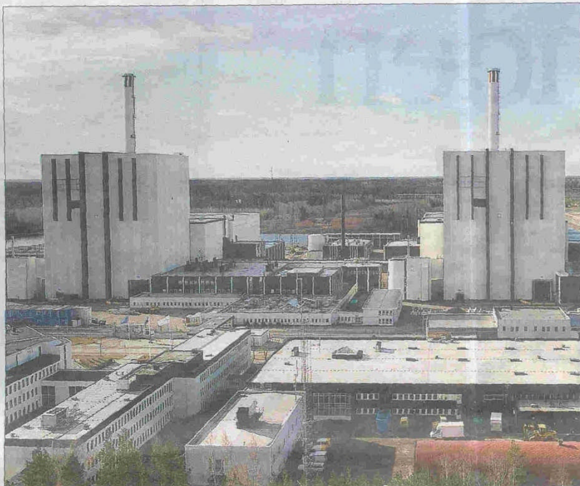
En kreativ lösning. Man kan bygga ett varmvattennät från Forsmarks kärnkraftverk som räcker till samtliga kommuner i Mälardalsregionen, hävdar debattörerna. FOTO: SCANPIX
